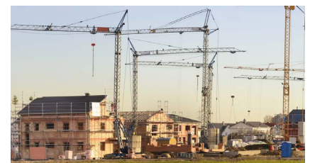
Der Staat will, dass sich im Wohnungsbau die Kräne drehen.
